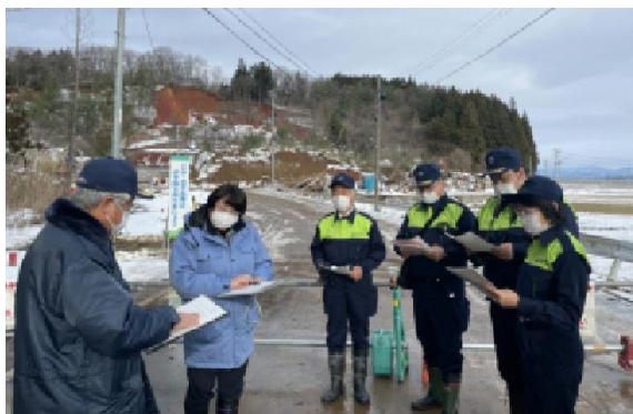
西目土砂崩れの現地調査(23. 01. 07)
