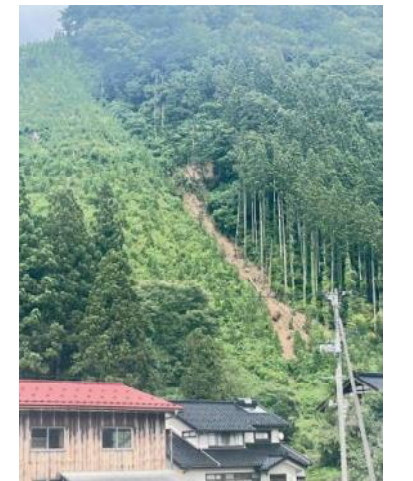
山五十川の土砂崩れ
