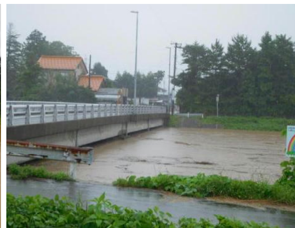
右・藤島元町の藤島川(藤浪橋)は、氾濫危険水位4.20メートルを2.68メートル超える最高水位6.88メートルを記録(25日18時40分)。写真は25日16時30分時点
