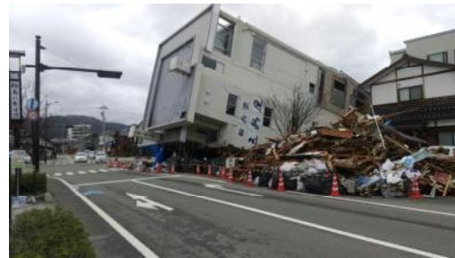
建物が倒壊し道路を塞いでいる
