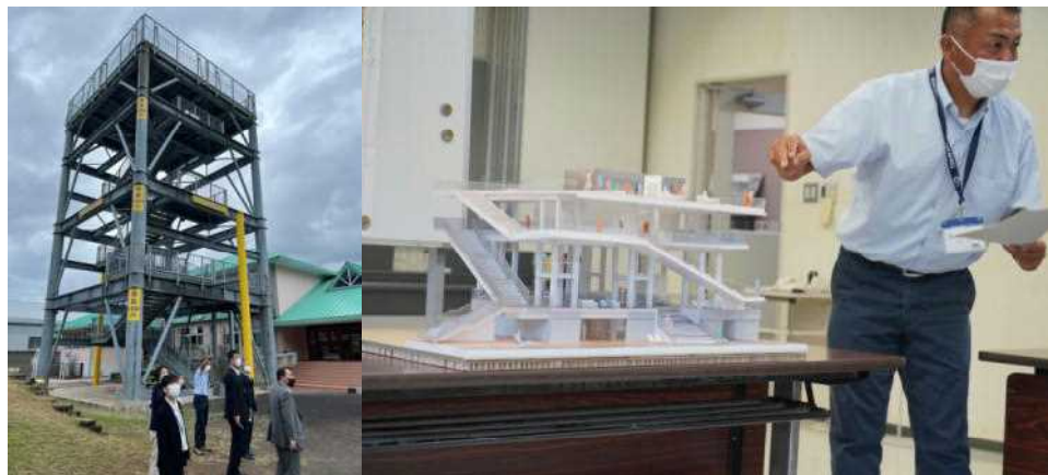
左・こども園に隣接する津波避難タワー、右・津波避難複合施設の模型
