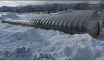
パイプハウスの倒壊 (高坂地内)
