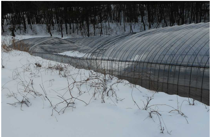
大雪で倒壊したビニールハウス(西郷地区内)
