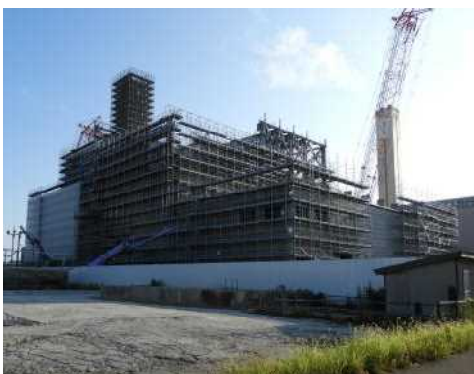
建設中のごみ焼却施設
