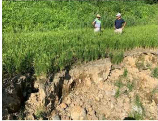
田麦侯の棚田が崩落した法面
