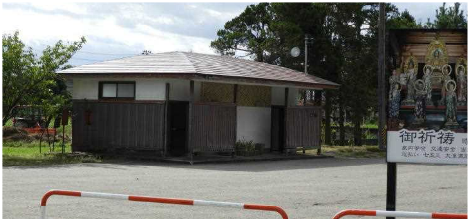
建て替え・バリアフリー化が計画されていた善寶寺の公衆トイレ
