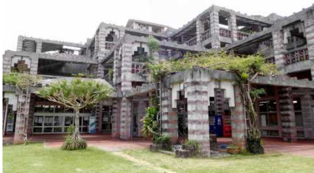
沖縄の風土に合わせた建築様式の名護市庁舎は1981年に建てられた
