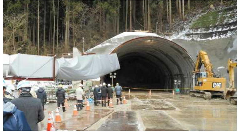
日沿道大岩川トンネルの工事現場
