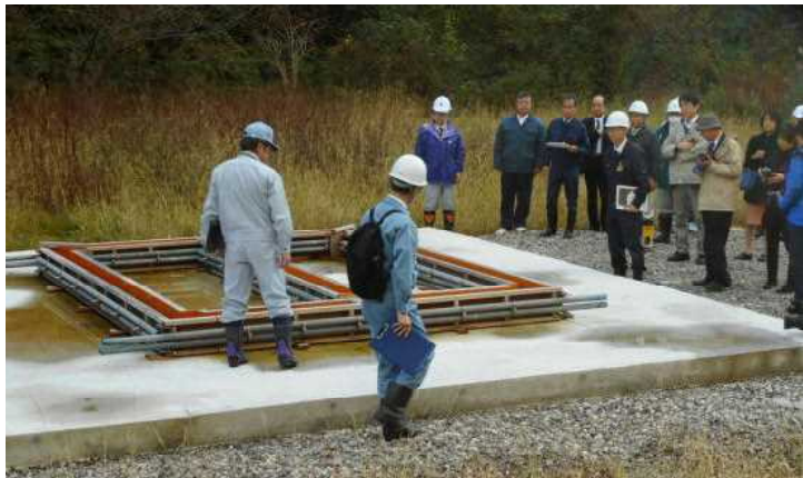
県が仮設火薬庫の基礎工事現場を確認
