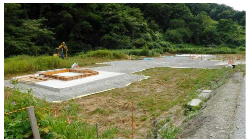
仮設火薬庫設置予定地(旧温海町早田)
