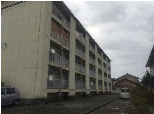
老朽化が進む市営住宅
