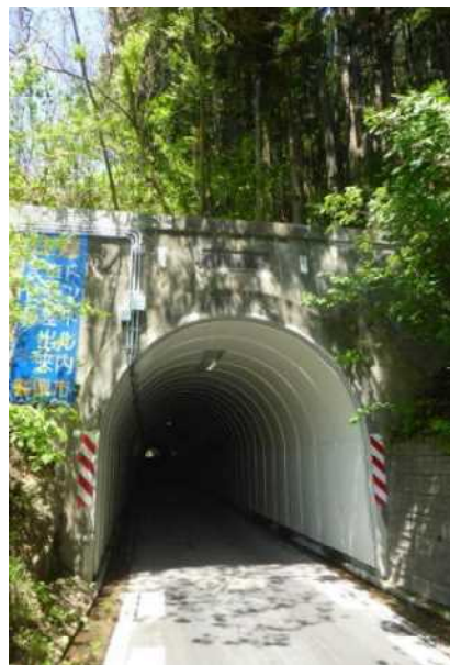
改修された神子沢隧道 (油戸～西目・竹の浦間)
