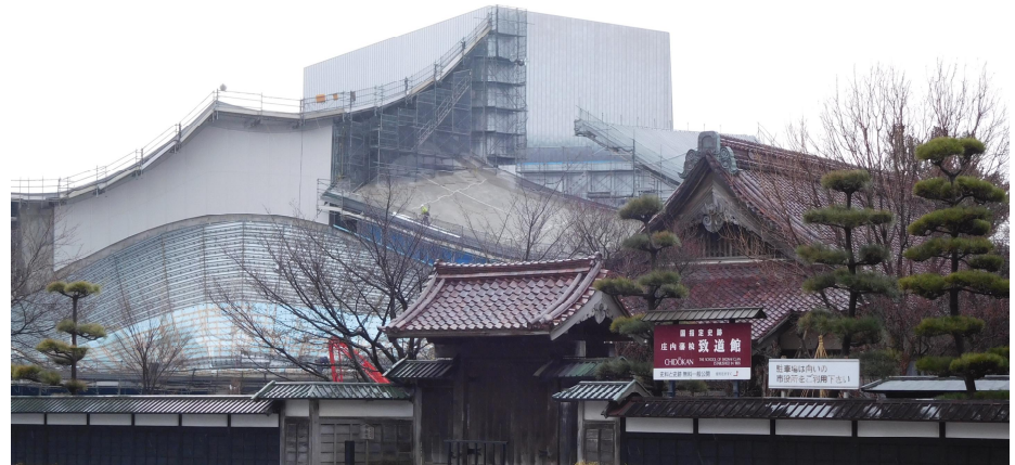
総事業費が96億7千万円にまで膨らんだ、建設中の新文化会館
