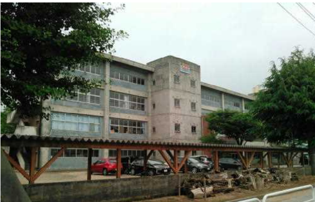
改築が予定されている鶴岡第三中学校 (7月4日撮影)
