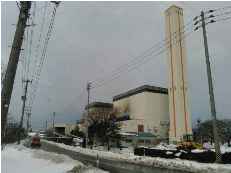
新焼却炉建設計画がある鶴岡市クリーンセンター。三川町のゴミ処理量は日量約8トで、単独処理施設建設は不可能
