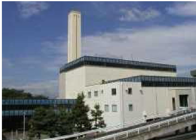
宝田三丁目にある鶴岡市クリーンセンター。老朽化に伴い新たな焼却炉の建設が計画されている。
