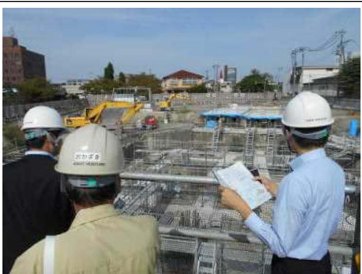
9月24日、新文化会館の建築現場視察が行われ、日本共産党市議団も参加しました。 現在、地下の基礎工事が進んでいます。 市民への一般見学会が10月12日（月）午後2回行われます。（要予約、申込み先・鶴岡市教育委員会）
