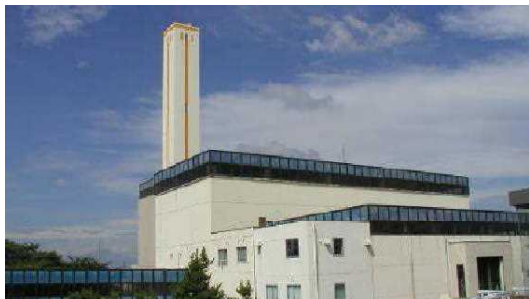
改築が計画されているごみ焼却施設
