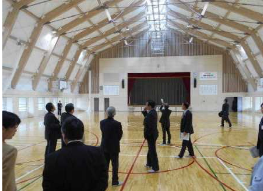
右上・鶴岡産杉材をふんだんに使った新校舎の外観、左上・吹き抜けで開放的な廊下に太い杉柱が並ぶ、右下・明るく広々とした教室、左下・杉集成材の太い梁が特徴的な体育館＝17日、朝日中学校
