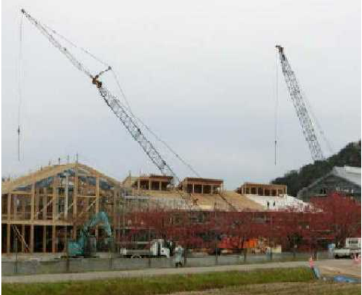
朝日中工事現場の様子(2014年10月)
