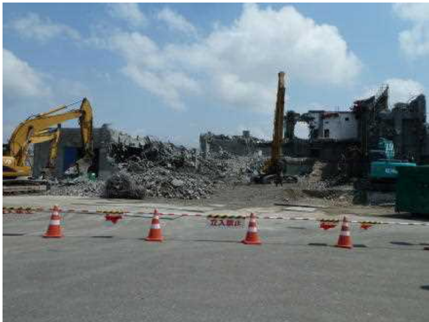
解体工事が進む旧鶴岡市文化会館
