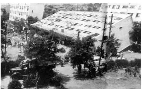
（新潟地震の液状化で、大きく傾いた県営アパート）
