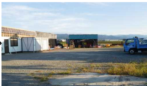
撤去、解体、整地された
