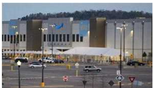
（米国内のアマゾン物流施設）
