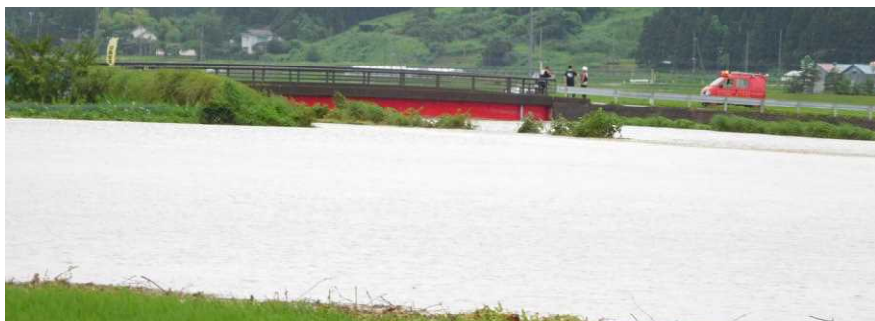
京田川（藤島関根）は越水し、通行止めになった
