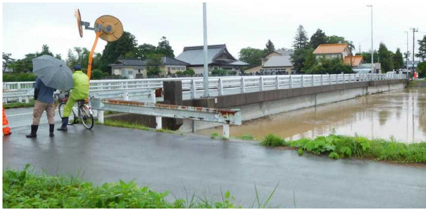
藤島川は、橋桁（はしけた）まで増水した経験がない（藤浪橋）
