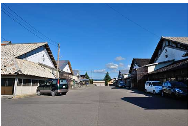
全農山形藤島倉庫
