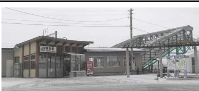
JR酒田駅に連絡が届いていますが、修繕が未定で対策が急がれます。
