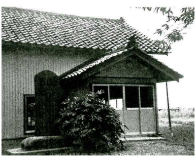
（古郡の揚水機場）
