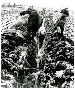
戦前における暗渠排水工事(藤島地区)
