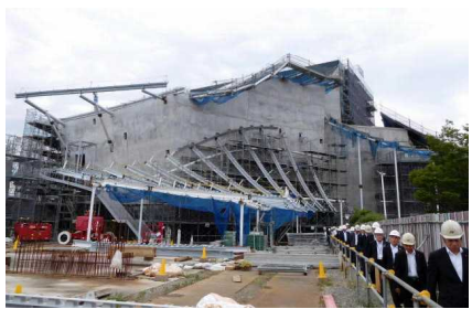
建設進む鶴岡市文化会館(9/26)
