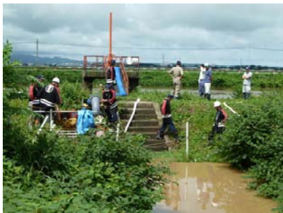
消防団が出動し、東北農政局の排水ポンプで排水作業(長沼・彦九郎堰水門)
